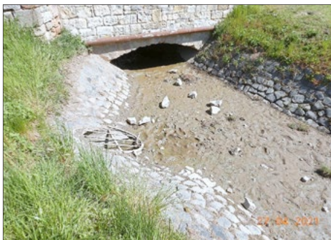
Überlauf Mischwasserpumpwerk in Bretleben
